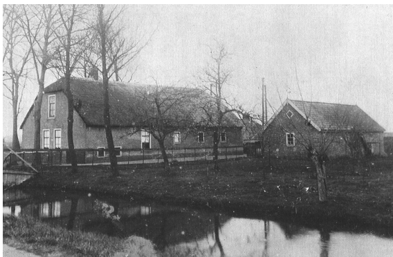
Boerderij uit ongeveer 1850 aan de Nieuwveenseweg 43 in Nieuwkoop.
